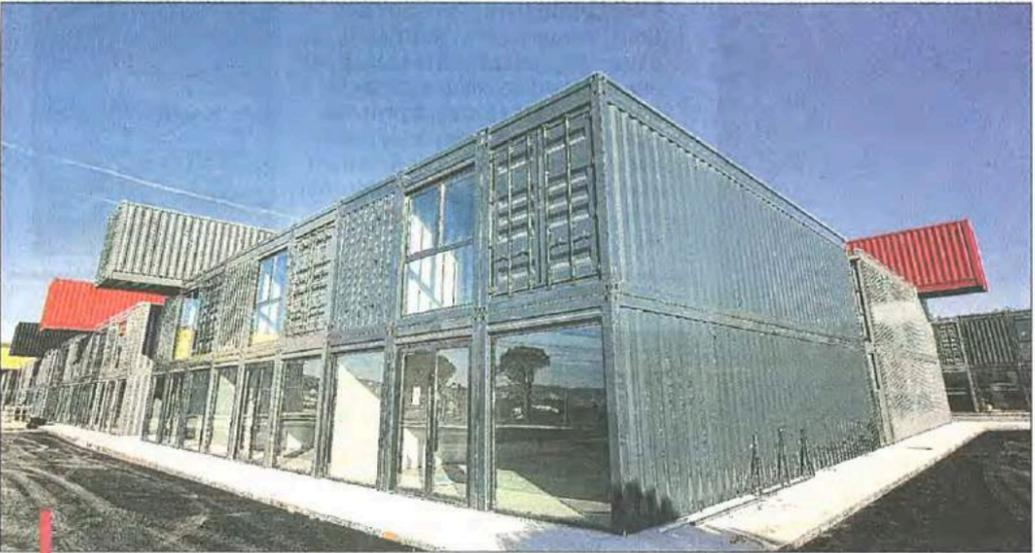
Les caractéristiques mécaniques du terrain ne permettant pas de creuser des fondations, les promoteurs ont opté pour une structure posée, à base de conteneurs maritimes. / PHOTOS PHILIPPE LAURENSON
