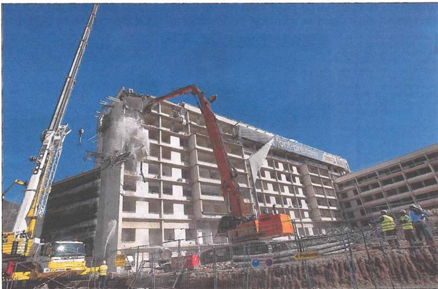
Après s'être attaqué dès 10 h au bardage métallique du bâtiment de 11 étages, le bras télescopique de 52 mètres de la pelle de démolition a commencé trois quarts d'heure plus tard à grignoter la grande barre.
