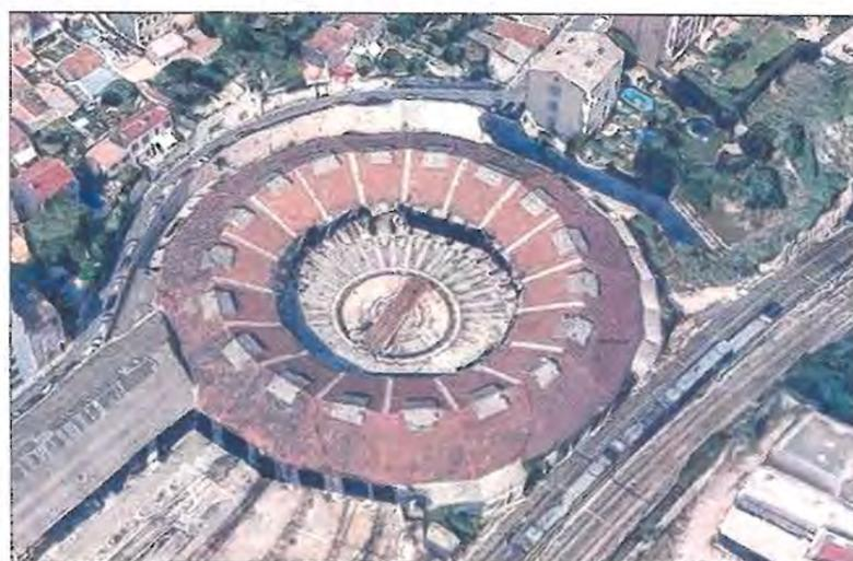
Construite entre 1886 et 1888, la "remise annulaire" mesure 90 mètres de diamètre. À l'époque, elle pouvait accueillir 32 locomotives simultanément. / IMAGE GOOGLE EARTH
