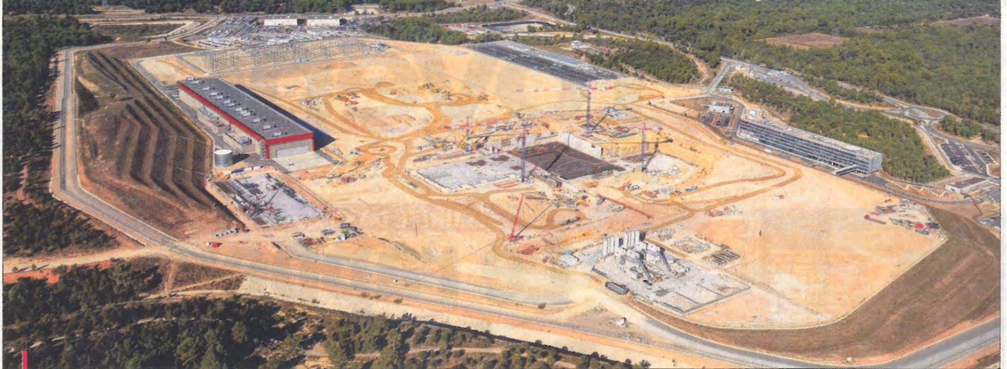
La plateforme de 42 ha sur laquelle le Tokamak va être construit. Entamée en 2007, la phase de construction devrait être achevée en 2019.
