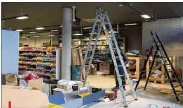
Les travaux ne sont pas tous terminés. Dans les rayons, les marchandises sont déjà installées. Les caisses attendent leurs premiers clients, sans doute ce mercredi matin. (P. NITO/CE)
