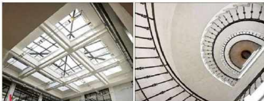
De la verrière du hall principal aux garde-corps des escaliers en colimaçon, la réhabilitation est réussie.
