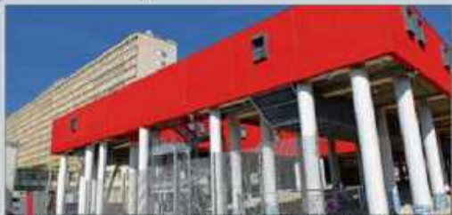
L'hôpital-prison, monté sur pilotis, est construit derrière Nord. (PHOTO: MARS 2008)
