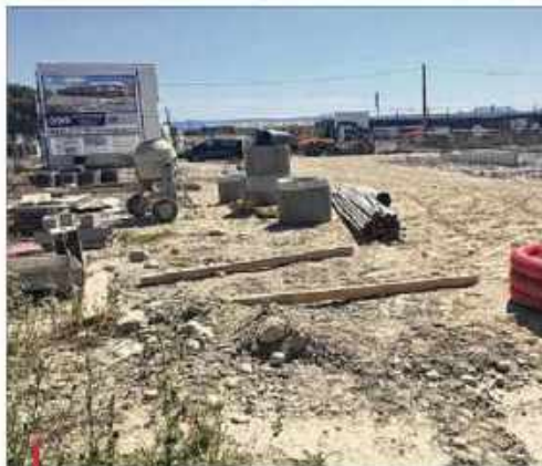
En lieu et place des friches industrielles des établissements Valais et Noble, de nouveaux commerces devraient ouvrir au printemps 2021.
