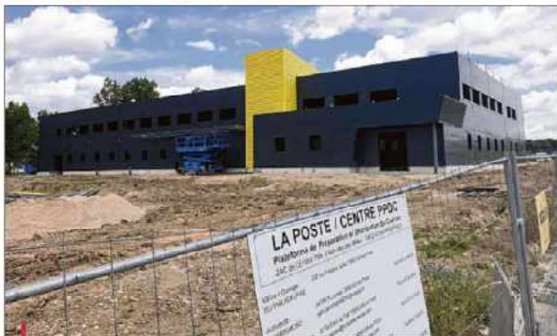
Le bâtiment de 6000m 2 construit aux Milles permettra de traiter la totalité des flux de la Poste au même endroit.
