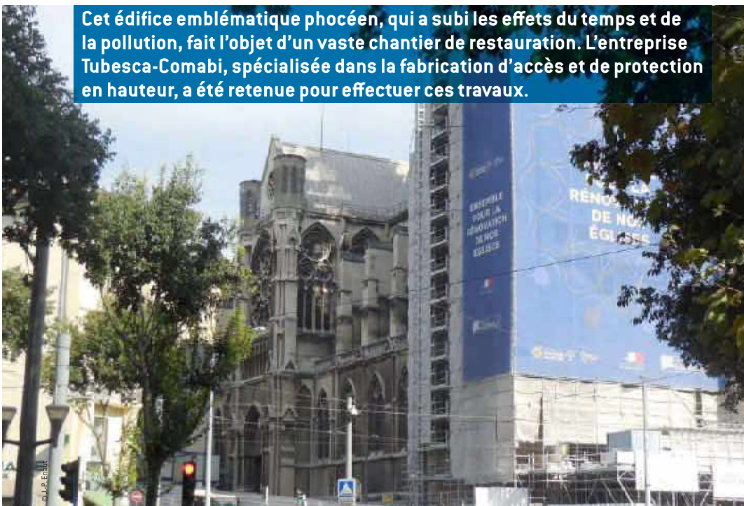
Le montage des échafaudages, qui a débuté en septembre 2019, s'est déroulé en trois étapes et a requis la mobilisation de 12 monteurs.
