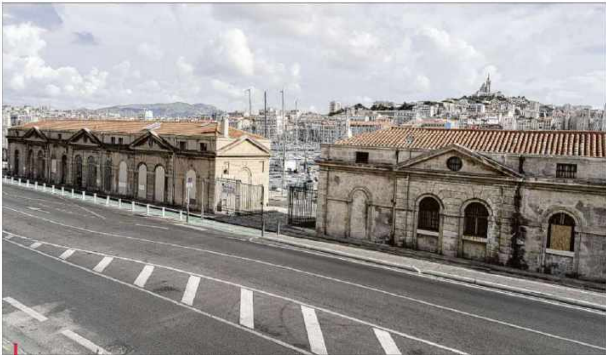
Considéré comme une priorité, il y a presque dix ans, le projet d'établir la capitainerie dans l'ancien bâtiment des douanes (à gauche), semble être tombé aux oubliettes.
