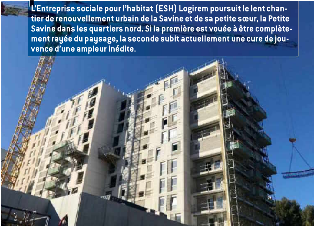
La Petite Savine en pleine rénovation.
