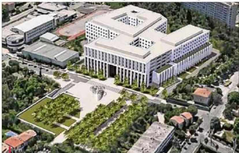
Bien que redimensionné, l'hôpital de 570 lits est jugé incompatible avec le quartier par le commissaire enquêteur.
