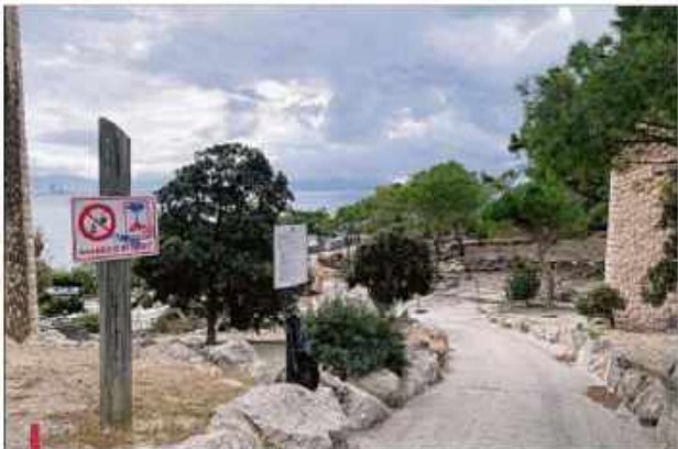
Depuis lundi, les travaux de restauration et de sécurisation ont débuté au parc de Corbières (16). Ils s'achèveront dans cinq mois.
