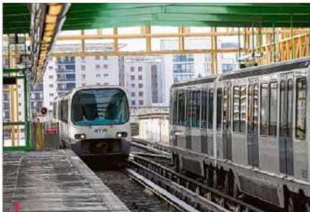
Sur le viaduc entre le stade Vélodrome et la station Sainte-Marguerite Dromel, la RTM procède au remplacement total des traverses. Un chantier qui empoisonne le sommeil des habitants. J. BOURGEOIS
