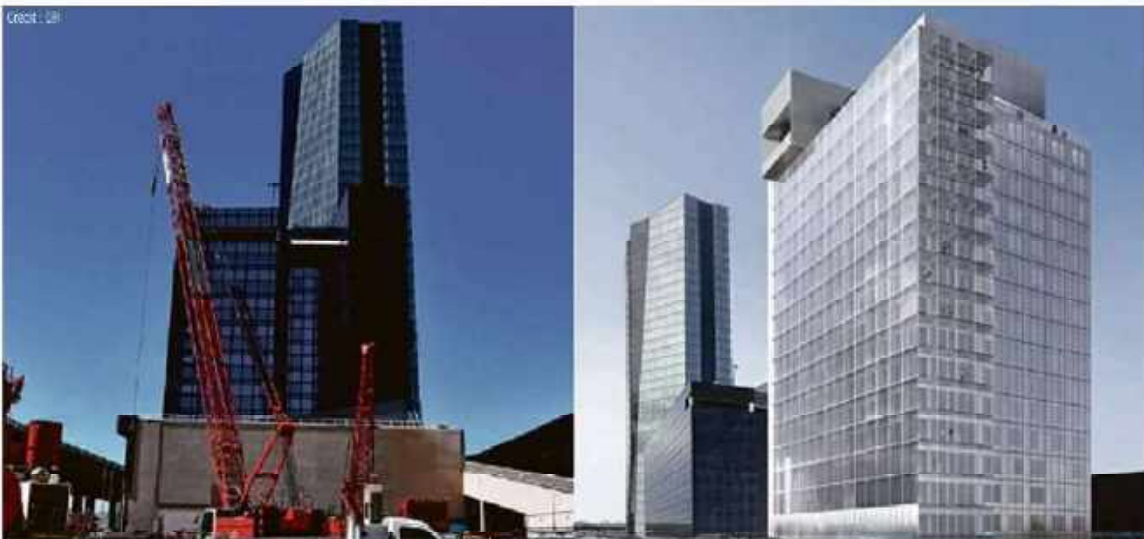
Sur une surface totale de 21 600 m 2 , les 21 étages de bureaux de la Tour Mirabeau ont été « conçus pour répondre aux nouveaux usages et modes de travail ».
