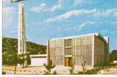
Après plusieurs années de chantier, l'église Notre-Dame d'Afrique est consacrée en mars 1966. /A. PROVINCE HISTOIRE
