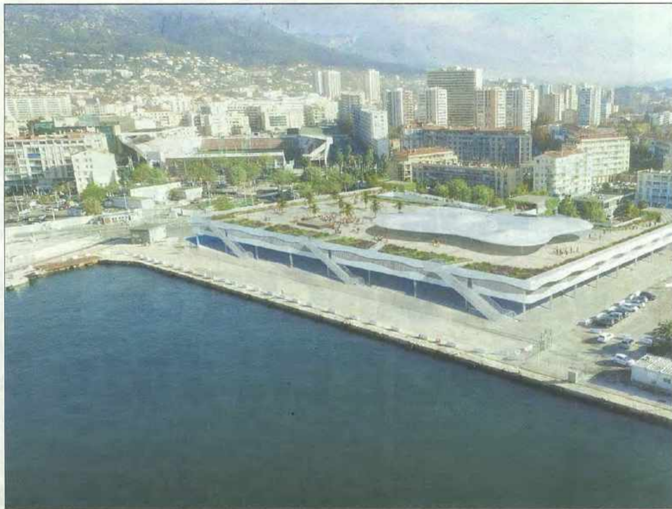
Pensé comme un projet d'architecture et une promenade urbaine, le futur parking-esplanade du Terminal passagers s'intégrera « dans le paysage urbain toulonnais. » (Photos Caire Architecture Golem Images)
