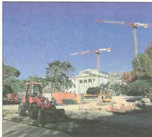
D'ici la rentrée 2019, les grues auront disparu.
