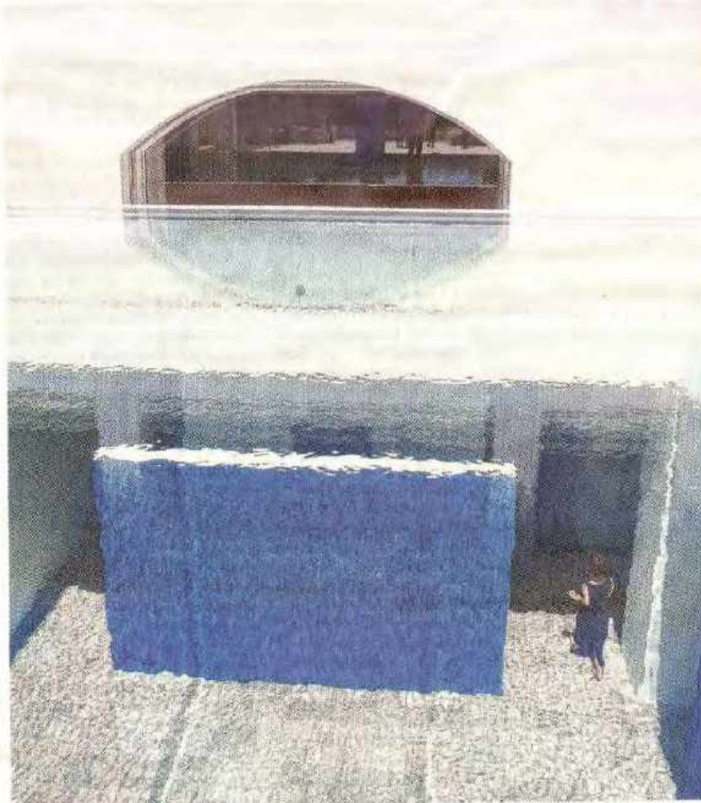
Ouverture entre intérieur et extérieur, une large dalle de verre couverte de plusieurs centimètres d'eau permet de voir les salles et les visiteurs depuis l'extérieur tout en amenant la lumière naturelle à l'intérieur et en la faisant vibrer sur les murs au gré des mouvements de l'eau. © DR
