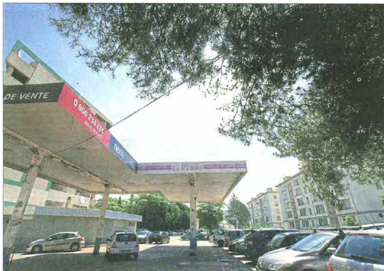
Le bâtiment de la station-service va être démoli. Les entrées et sorties du parking seront sécurisées.
