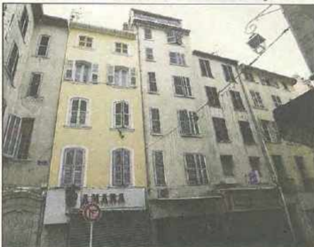
À l'angle des rues de La Boucherie et de Jean-Aicard, un pan d'immeuble va être démoli, ce qui créera une belle ouverture sur la place Vincent-Raspail.
