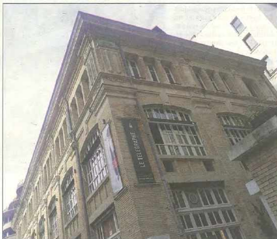
Le lieu a été mis aux normes en vue d'une ouverture prochaine. Copie rendue aujourd'hui !
