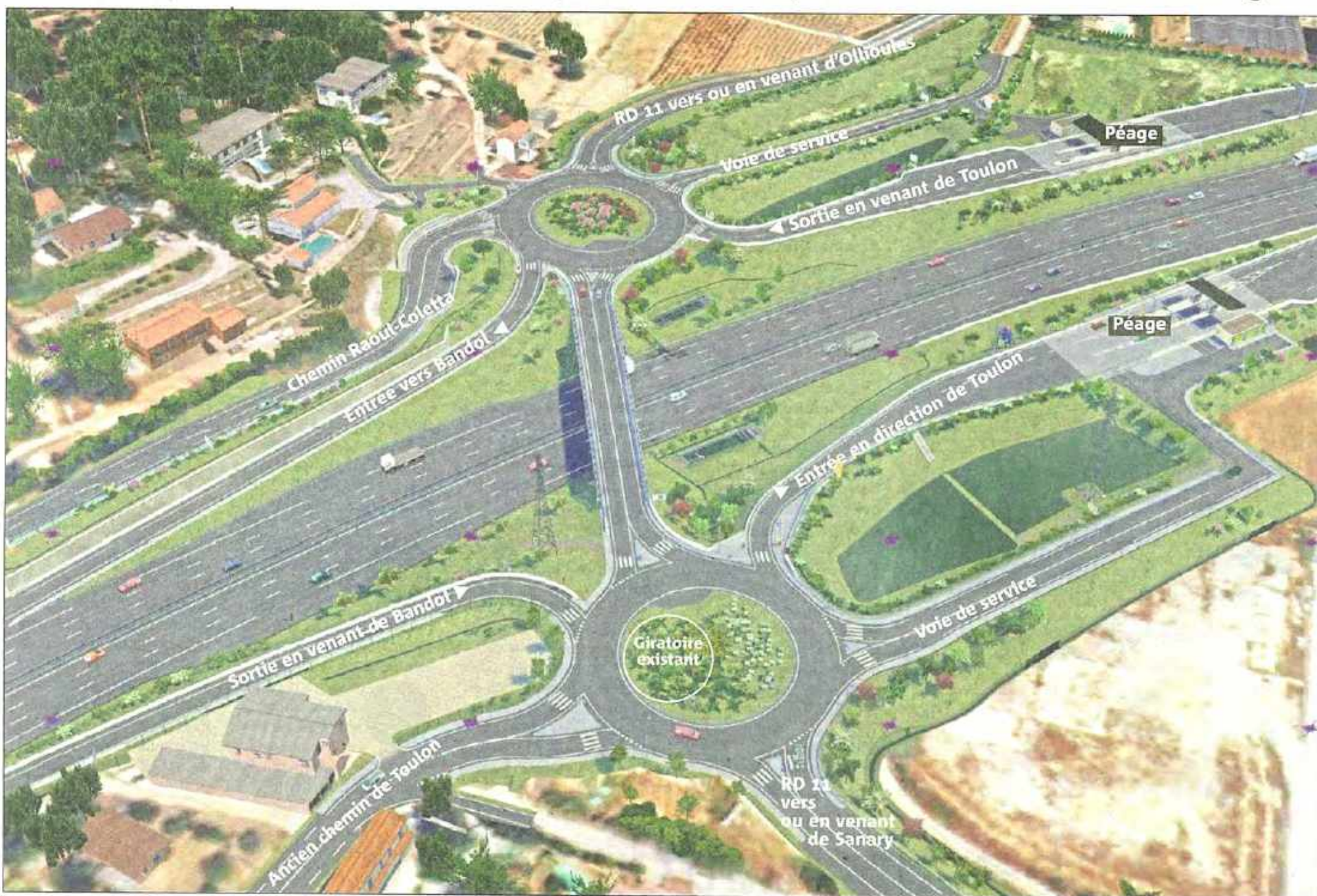
Les deux giratoires en cours de construction seront mis en service avant la fin de l'année. Puis débiteront la construction des bretelles et des gares de péage.
