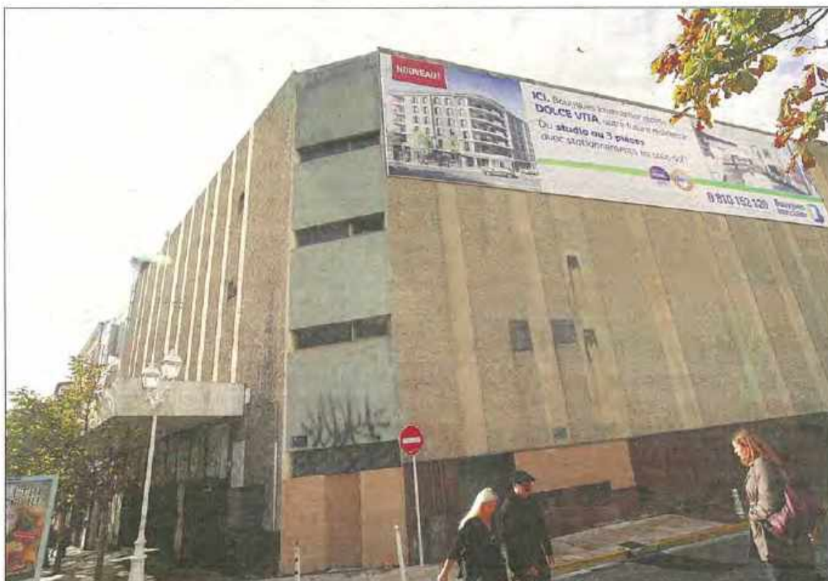
Le promoteur Bouygues Immobilier, toujours en lien avec la SARL, propriétaires de l'ex-Ariel pour qui la première promesse de vente est tombée durant le temps de la juridiction, continue de travailler sur le dossier. Un nouveau permis de construire devrait être déposé. (Patrick Blanchard)
