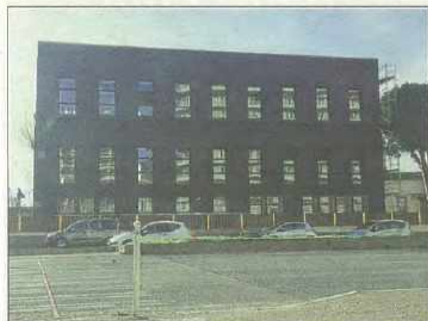
La façade, actuellement en travaux.
